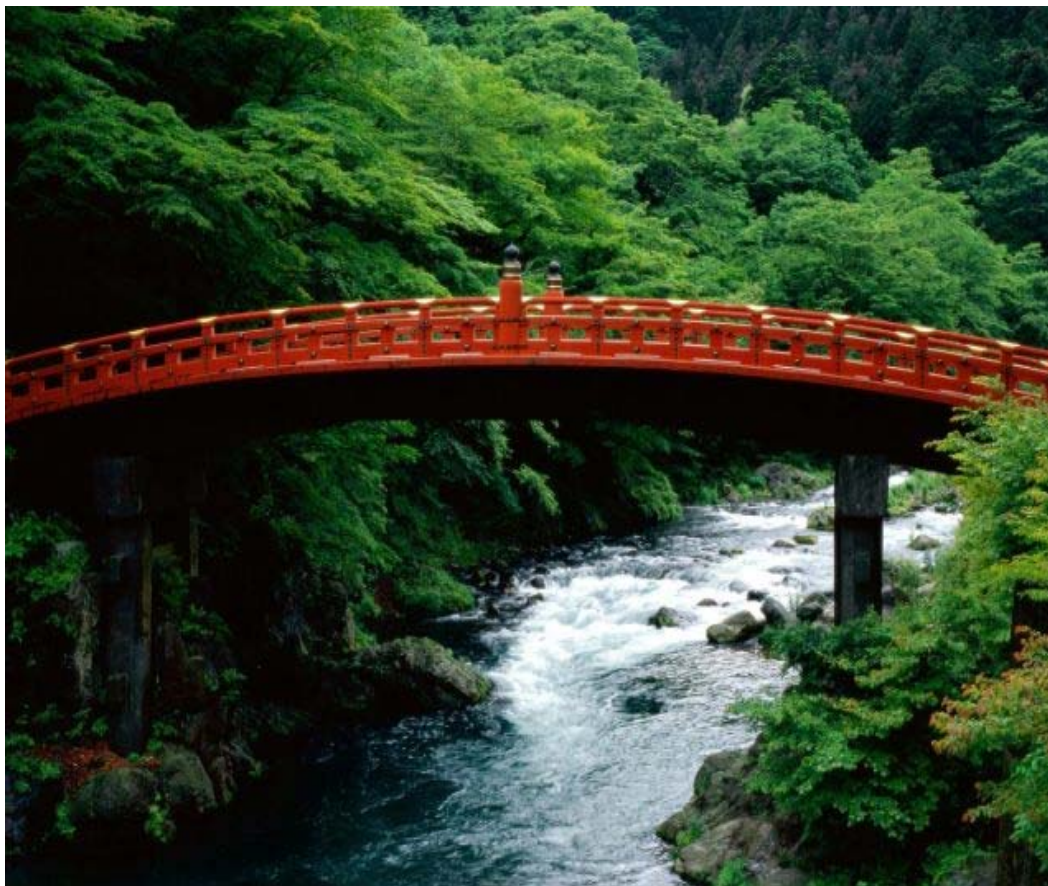
Figura 25 Ponte sobre o rio Daiya, Japão
