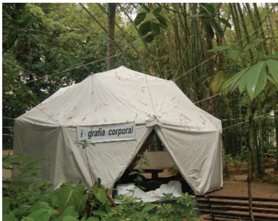
Figura 38: tenda geodésica, sustentada por cabos de nylon, amarrados nos troncos das árvores.
