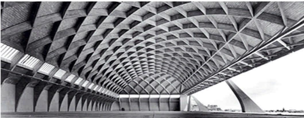
Figura 03: Hangar em abóbada lamela construída por Pier Luigi Nervi
