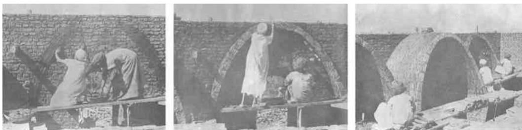
Figura 25: Processo de execução da abóbada Núbia
