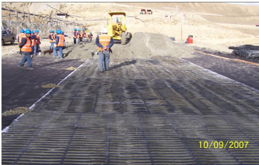
Figura 4.1 – Instalação de geogrelha e colocação de material de rejeito na construção do aterro reforçado (Peru).
