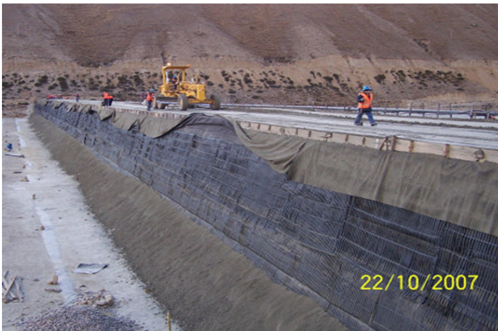
Figura 4.2 – Construção da etapa final do aterro reforçado com geossintéticos na barragem de rejeitos III da mina San Rafael (Peru).
