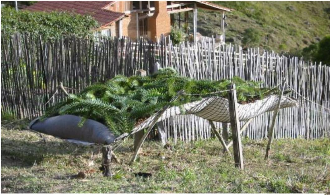
Figura 188. Cobertura verde já distribuída com definição das curvaturas provocadas pelo peso próprio.
