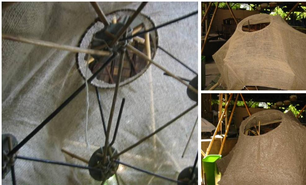
Figuras 208, 209 e 210. Estrutura geodésica em escala reduzida com suporte e modelagem em fibrosolo.
