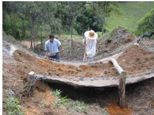
Figuras 148 e 149. Montagem de estrutura da cobertura com manta de juta
