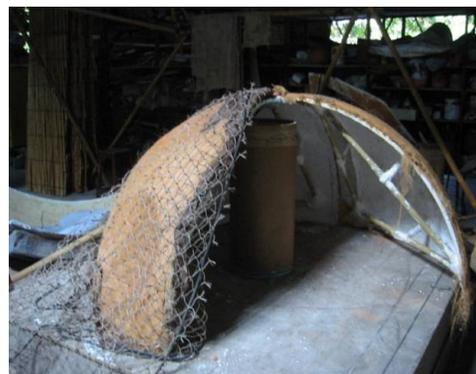
Figura 229. Montagem de cúpula com moldes
