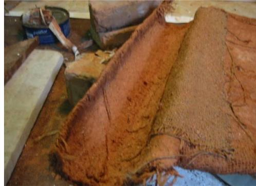
Figura 218. Bandagem de recomposição da peça calha/telha
