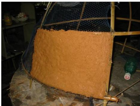
Figura 196. Modelo com malha tensionada parcialmente barreado.
