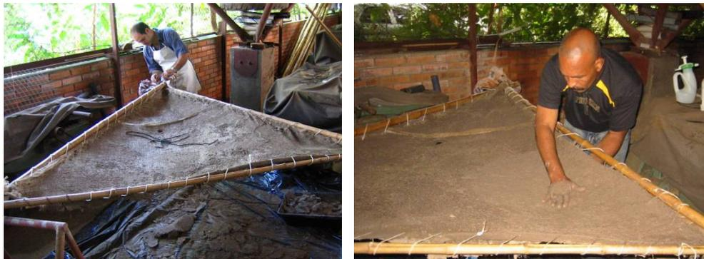
Figuras 204 e 205. Preparo de manta tensionada e costurada em moldura de bambu com início de aplicação de fibrosolo
