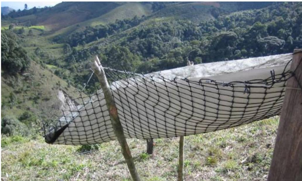
Figura 187. Malha tramada tensionada pelo peso próprio da cobertura verde.
