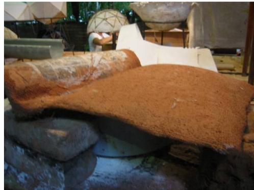
Figura 220. Calha laminada com fibroso e revestimento de jornal com PVA pronta para emenda.
