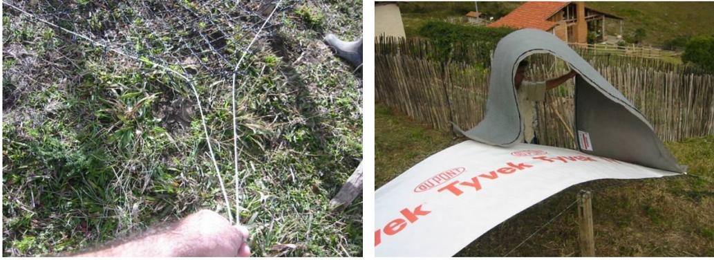
Figuras 183 e 184. Armação e montagem de estrutura tensionadas suspense com as mantas de proteção e de drenagem
