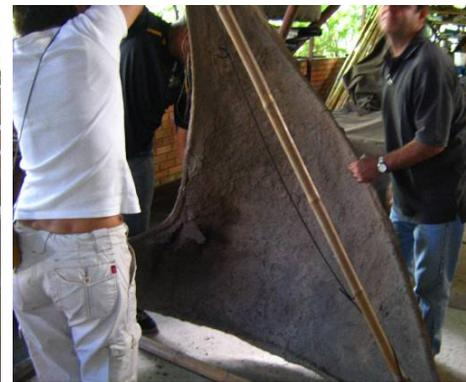
Figuras 202 e 203. Apoio e manejo da casca curada, mostrando a necessidade de estruturação da superfície inferior devido ao peso próprio.
