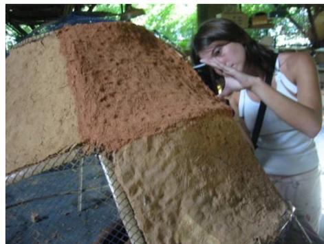
Figura 197. Aluna aplicando compósito sobre modelo.
