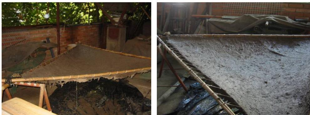
Figuras 206 e 207. Casca com curvatura provocada por peso próprio do material
