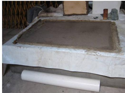
Figuras 276, 277, 278 e 279. Processo de confecção de folha pré-tensionada de fibrosolo.
