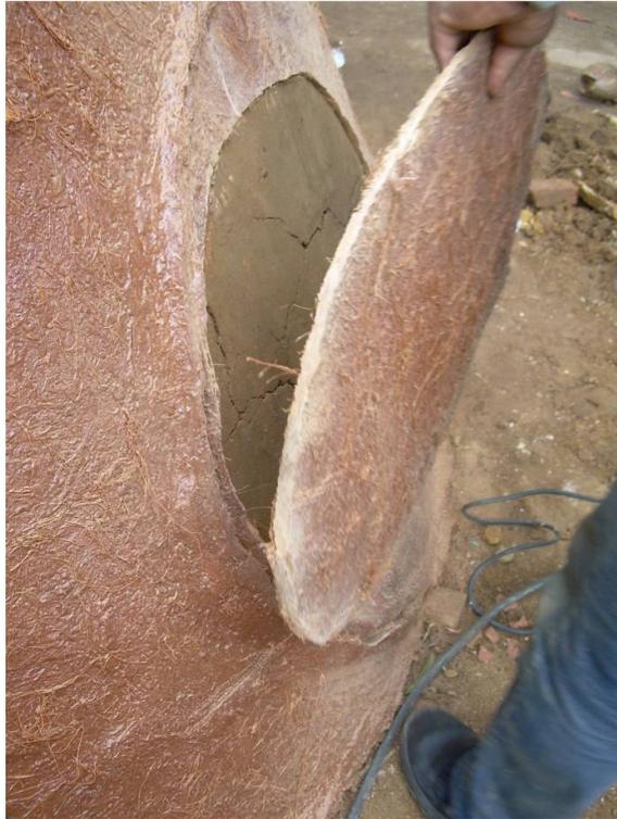
A desmoldagem também se mostrou mais complexa, não pelo princípio que é bem simples, mas pelo manejo e cuidado no serviço. A retirada de material requer certo esforço, que foi simplificado com a abertura de uma passagem circular próxima à base. A ogiva assim se consolidou.
