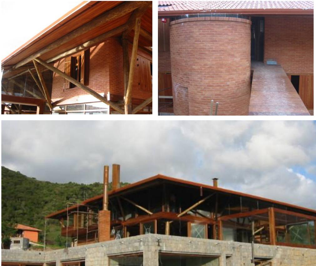
Figuras 153, 154 e 155. Obra da Cachoeirinha construída em adobe e revestida com tijolos de olaria local. Também em estrutura independente de eucalipto autoclavado e base de pedra.
