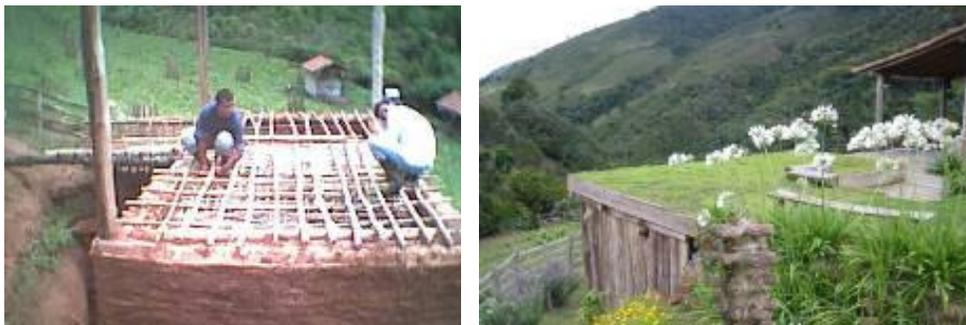
Figura 158 e 159. Montagem de estrutura para cobertura vegetal em abrigo utilizando técnica de tramado no bairro Jequiri.
