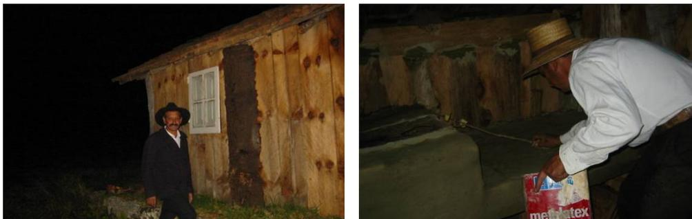
Figura 156 e 157. Abrigo de pouso para viajantes construído no bairro Barreiro feito com tabuas costaneiras de araucária e vedado com mistura de barro e esterco. Internamente foi construído também fogão a lenha e piso com mesma mistura .
