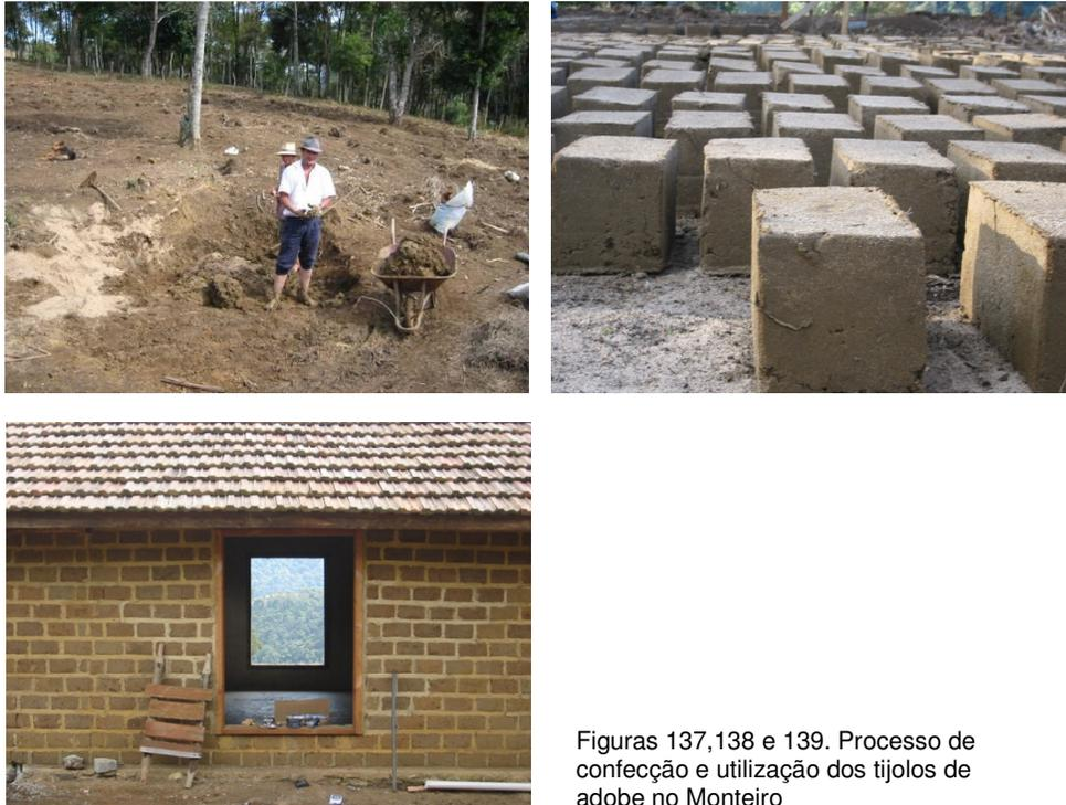
Figuras 137, 138 e 139. Processo de confecção e utilização dos tijolos de adobe no Monteiro
