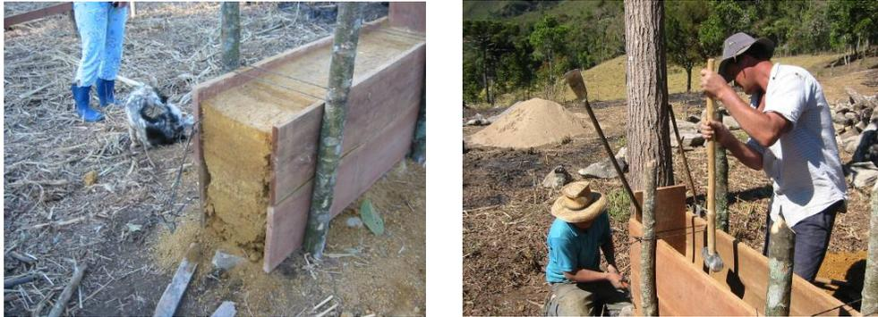
Figuras 134 e 135. Técnica de taipa de pilão aplicada experimentalmente no Monteiro
