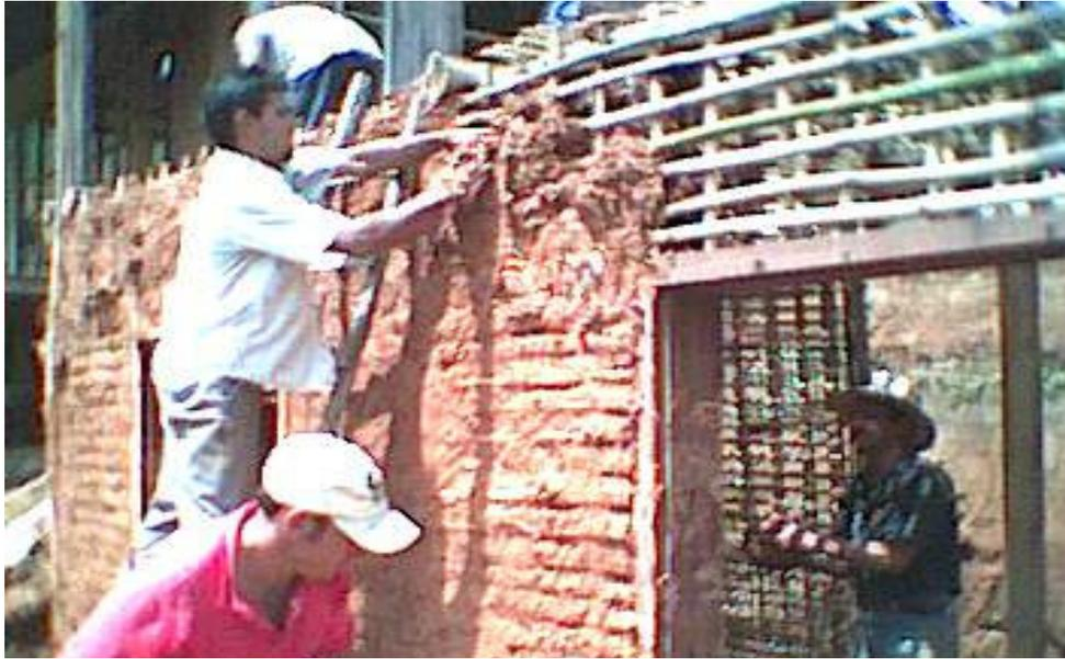
Figura 136. Equipe aplicando a técnica de taipa de mão sobre armação de pau-a-pique no Monteiro
