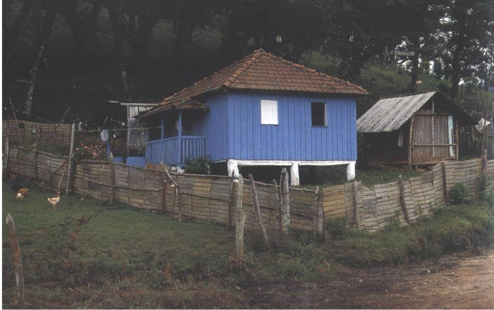
Figura 132. Moradia da região da Mantiqueira construída com técnica das tabuas
