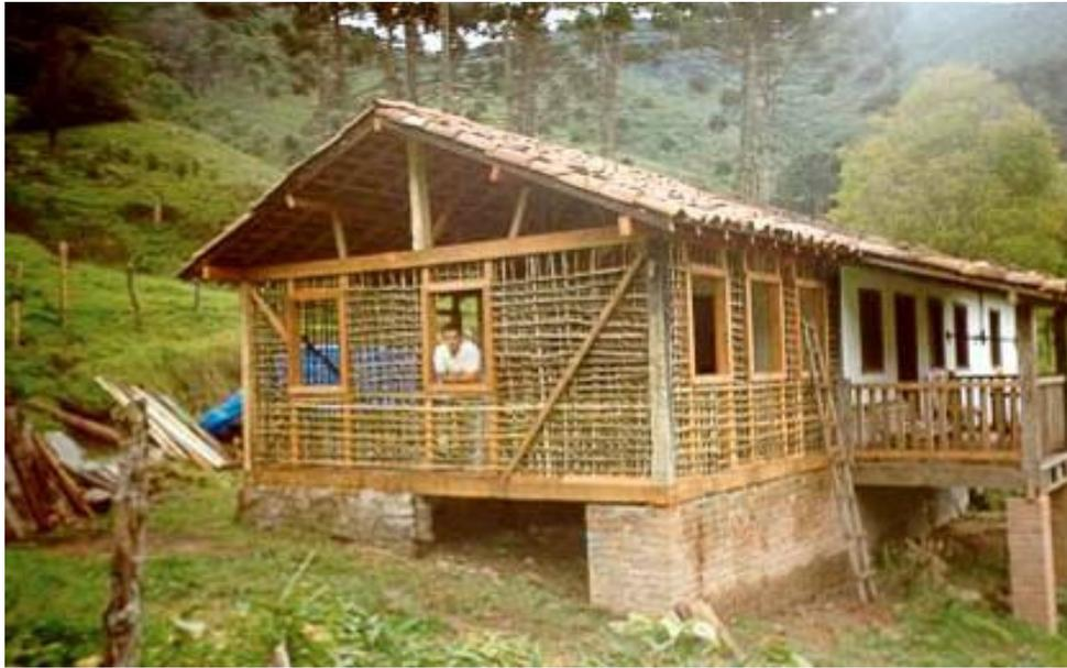
Figura 131. Construção com técnica enxaimel português com resquícios de técnica alemã no bairro Cachoeirinha em Itamonte-MG
