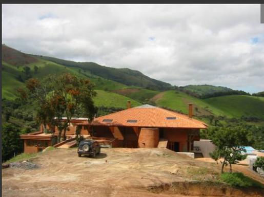
Figuras 27, 28 e 29. Etapas de construção da obra da Cachoeirinha. Também foi utilizado o princípio de estrutura independente em eucalipto e alvenarias de adobe revestido de madeira e tijolinhos.
