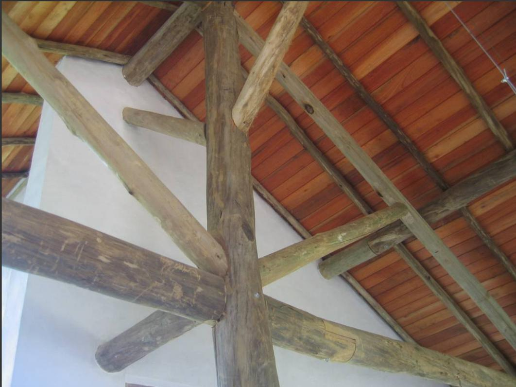
Figura 23. Detalhe da estrutura independente em eucalipto com alvenaria de adobe
