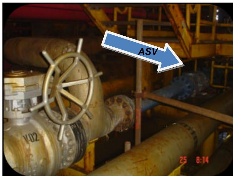
**Figura 34 – Instalação do ASV na plataforma de PCE-1.**
