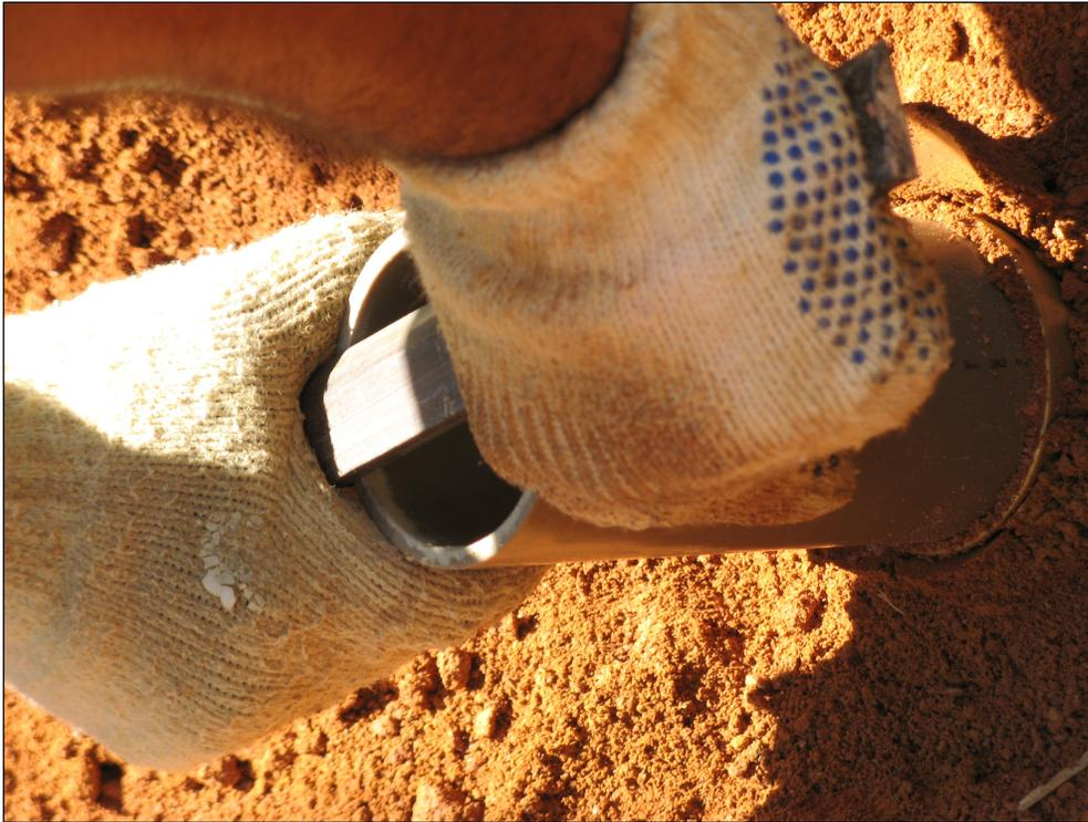
Figura 3.13 – Cravação da coluna de PVC com auxílio de um bisel.
