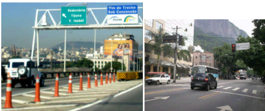
Fig.1.8- Sinalizações verticais (placas), horizontais (faixas brancas no asfalto), auxiliares (cones laranjas, marcadores zebraados de perigo na mureta).
