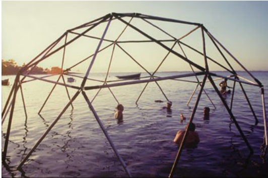
Domo geodésico realizado pelo LILD, em bambu amarrado por juntas metálicas.(LILD).
