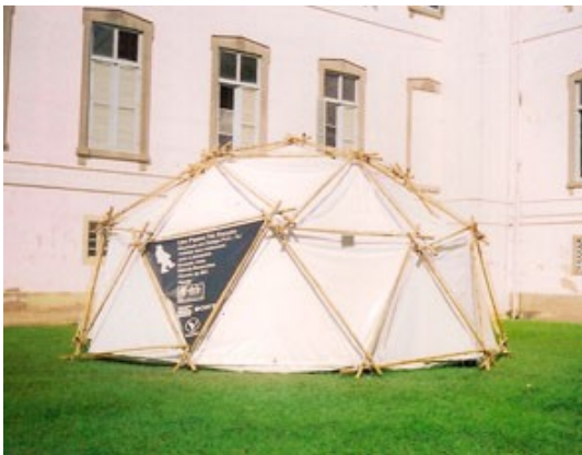
Sala escura para experiências táteis com videntes e não videntes. Arquitetura tensegrity em bambu e cabos. Vedação com lona vinílica. (LILD)
