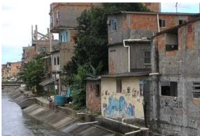
Moradias da comunidade de Rio das Pedras, ao longo do rio
