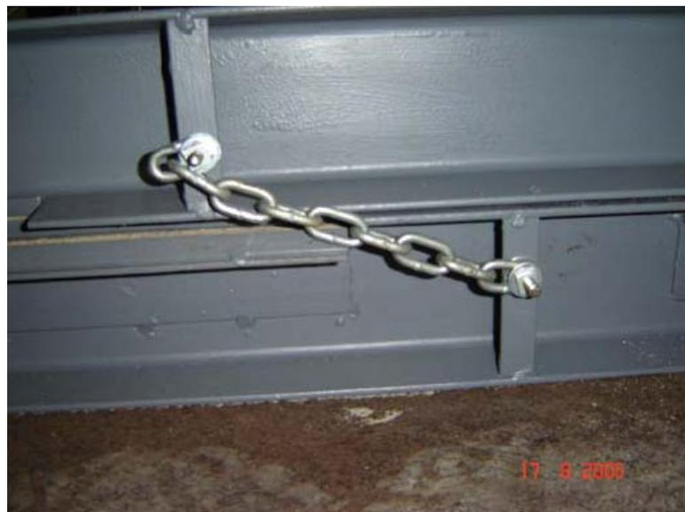
Figura 84 - Limitador de deslocamento (esticado).
