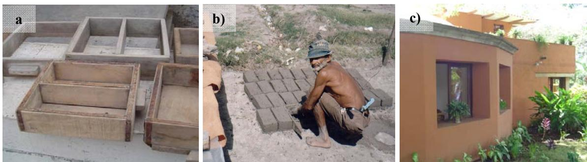
Figura 10. Fôrmas, fabricação e construção em Adobe (BARBOSA e GHAVAMI, 2007).
