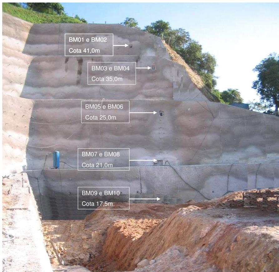
Figura 46 – Posição de retirada dos blocos.
