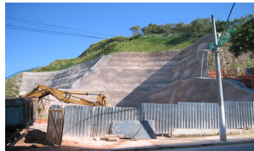
(f) Vista lateral da parede grampeada (março de 2005)
