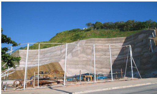
(g) Vista lateral da obra em fevereiro de 2005
