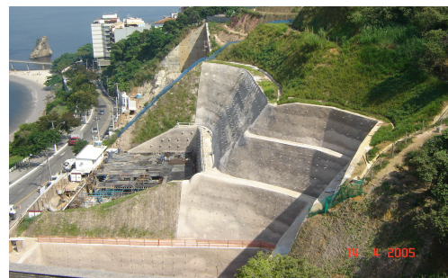
(h) Visão superior com obra totalmente concluída (abril de 2005)
