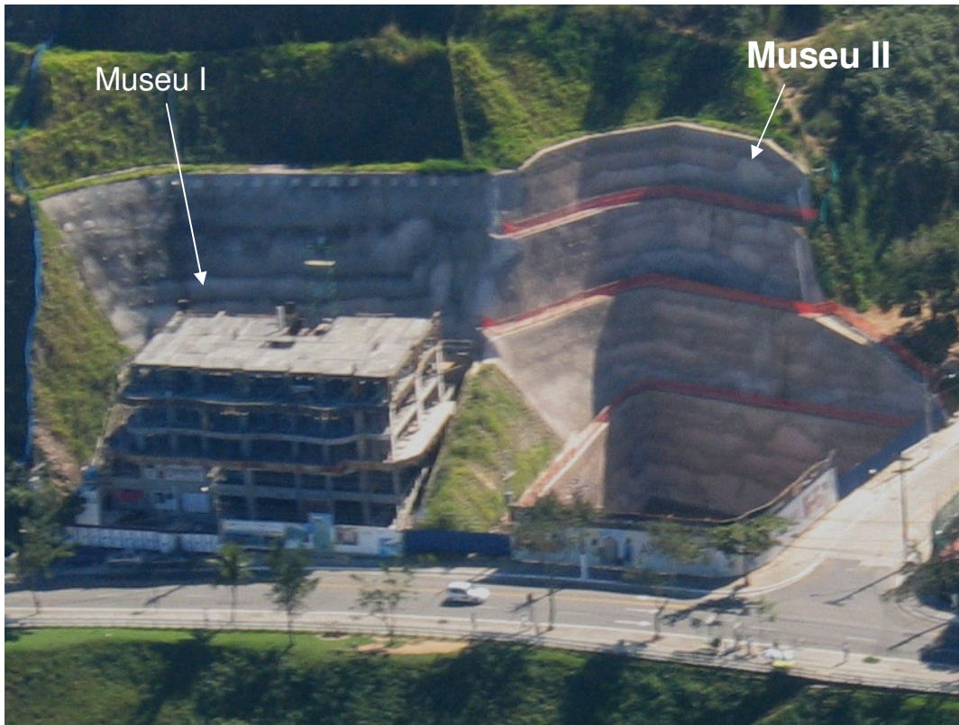
Figura 37 - Vista aérea das escavações grampeadas.
