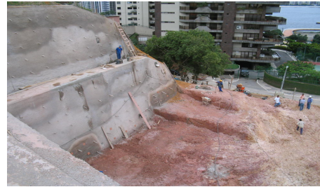
(d) Primeiro talude executado e segundo em execução (dezembro de 2004)
