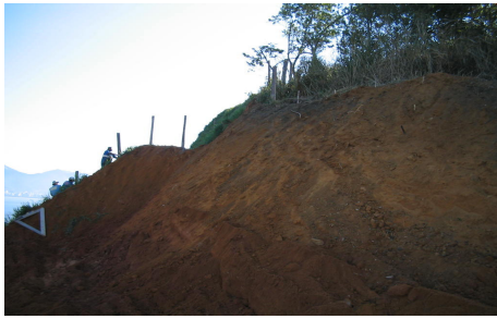
(a) Início dos serviços de escavação (agosto de 2004)
