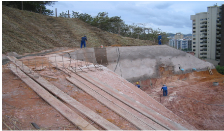
(c) Talude superior executado e primeiro talude em execução (outubro de 2004)
