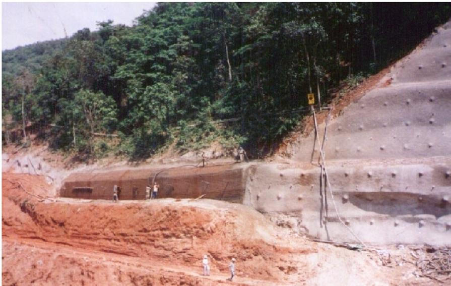
Figura 4 - Fases executivas em solo grampeado: escavação, instalação dos grampos e contenção completa (Linha Amarela, Rio de Janeiro, foto GeoRio).
