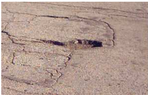
Figura 6.03 – Depressão na pista. Pode ser verificada como uma combinação dos gráficos mostrados pela figura 5.14.
