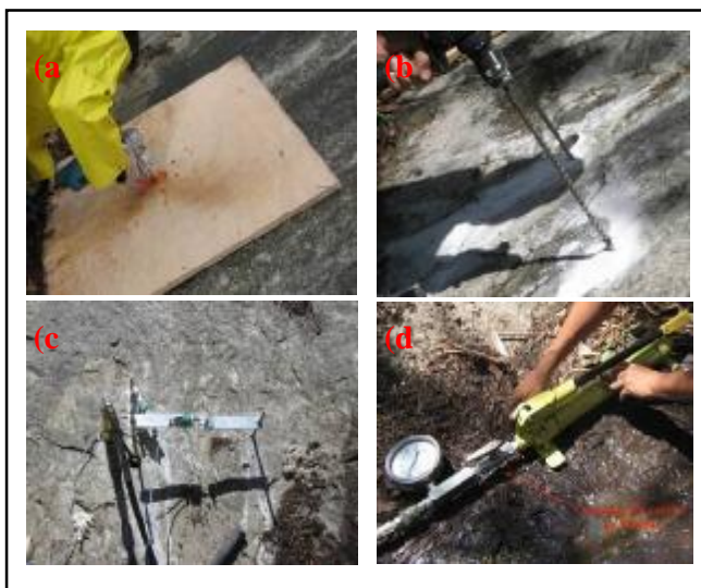
Figura 7.9 – (a) Direcionando o furo central, (b) momento da perfuração dos pinos com o martetele, (c) LVDT's montados para o início da pressurização, (d) macaco hidráulico (detalhe da válvula instalada para controlar o fluxo de óleo).
