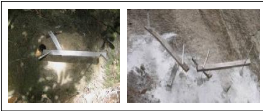
Figura 6.6 – Sistema de suporte para os sensores de deslocamento (LVDT's).
