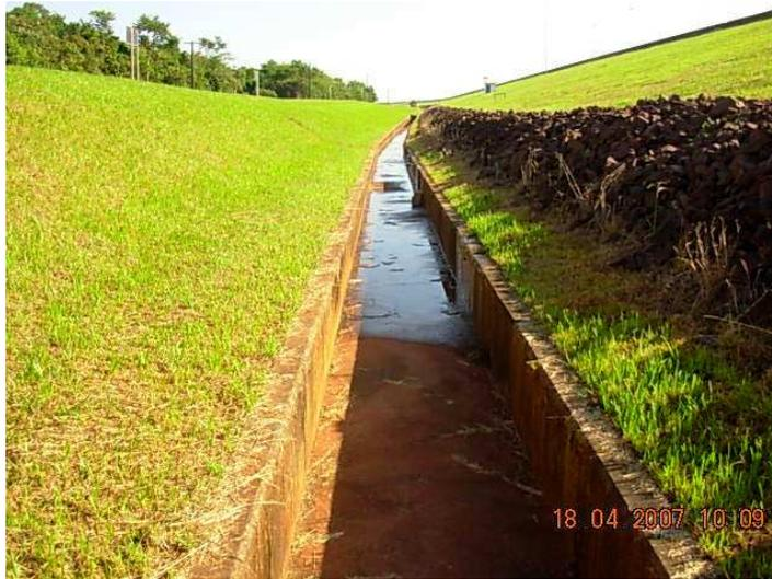
Foto 1 – Canaleta de drenagem próxima à ombreira esquerda
