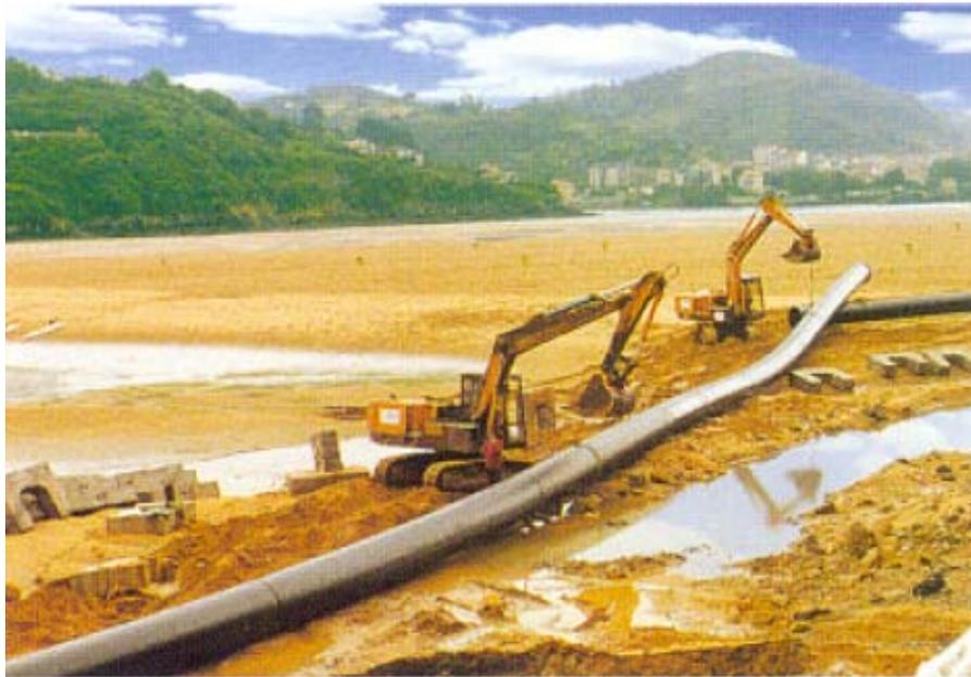
Figura 2.9: Instalação de uma tubulação de PEAD [15]
