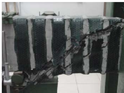
Figura 2.6 – Foto de uma viga de concreto armado reforçada com CFRP colado envolvendo completamente a seção transversal da viga, em faixas e com \beta = 90^\circ , após a ruptura, devido à ruptura do reforço; retirada de Beber (2003).
