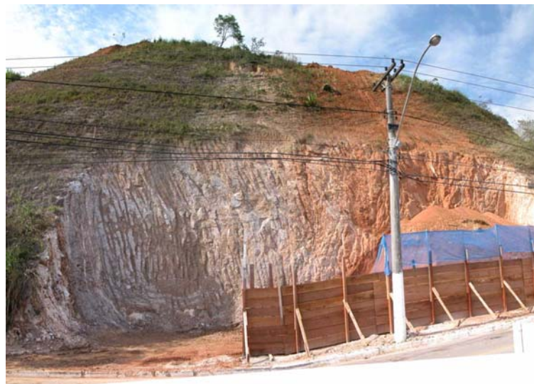
(a) Vista do talude em 25/11/2003
