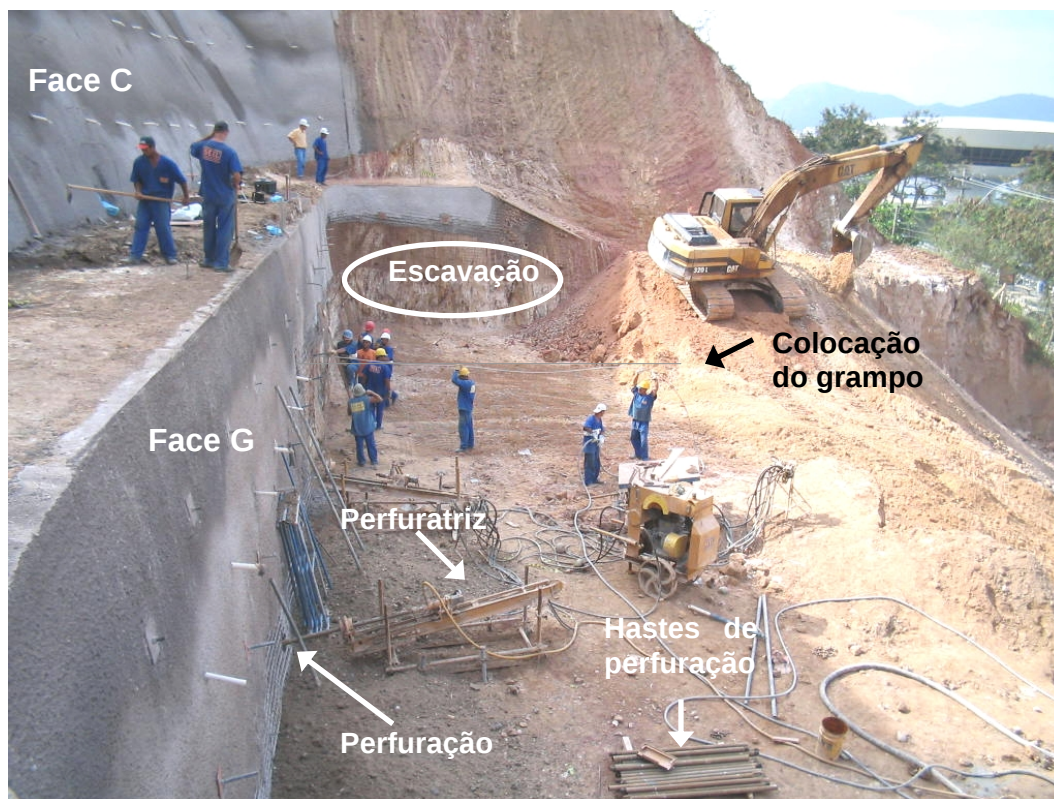
Figura 91. Vista geral das etapas construtivas.
