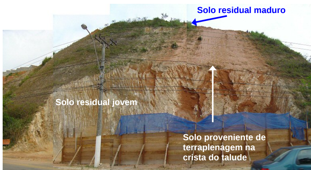
Figura 80. Detalhe do talude em 11/12/2003.
