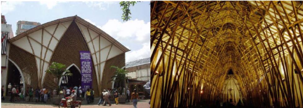
Figura 2.7 - Vistas frontal e interna da Catedral construída em bambu na Colômbia. Fonte: Ghavami (1992).
