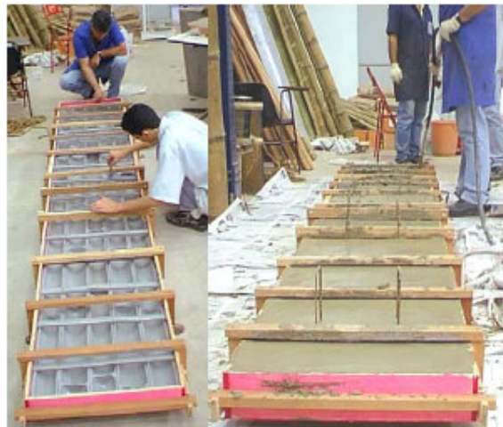
Figura 2.3 - Tratamento e concretagem de lajes armadas com bambu. Fonte: Achá (2002).
