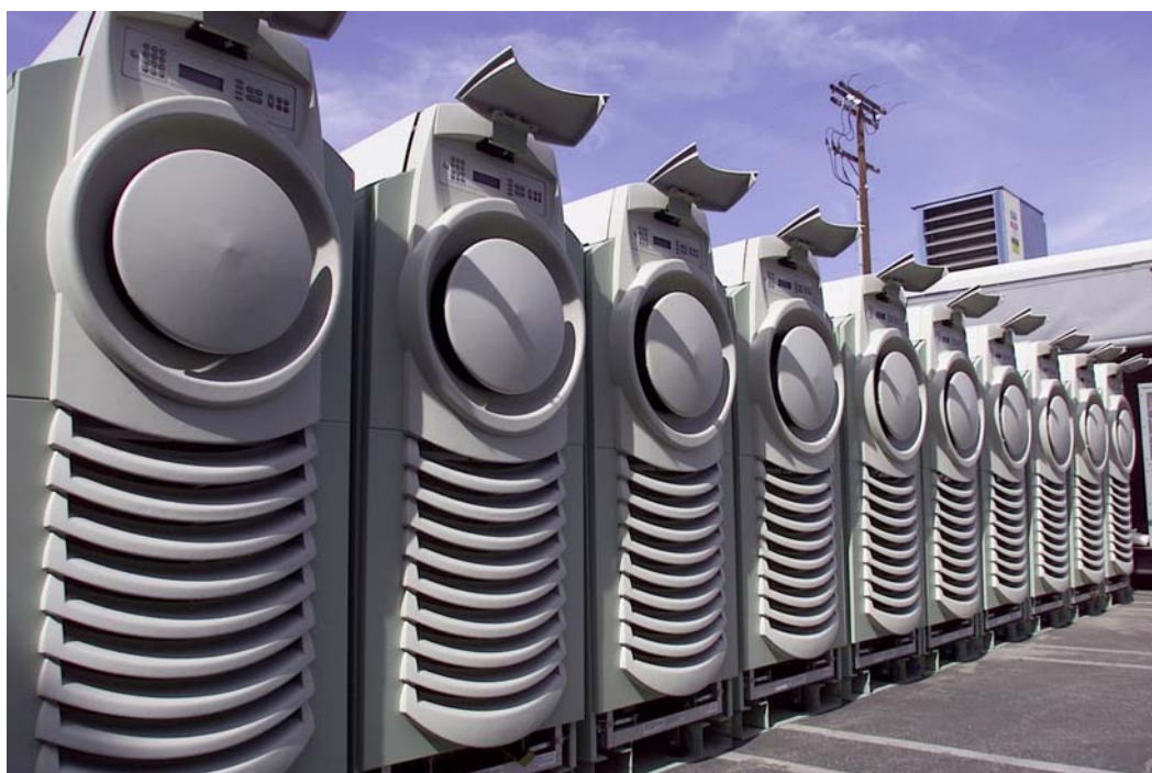
Figura 6 - Microturbinas Capstone – Modelo 330 (30 kW) - 10 unidades.
