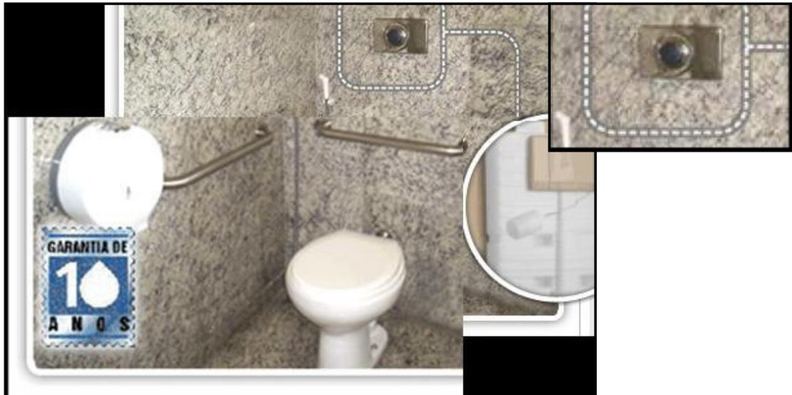
Figura 45 - Caixa de Descarga embutida Montana e seu detalhe. (MONTANA, 2006)
