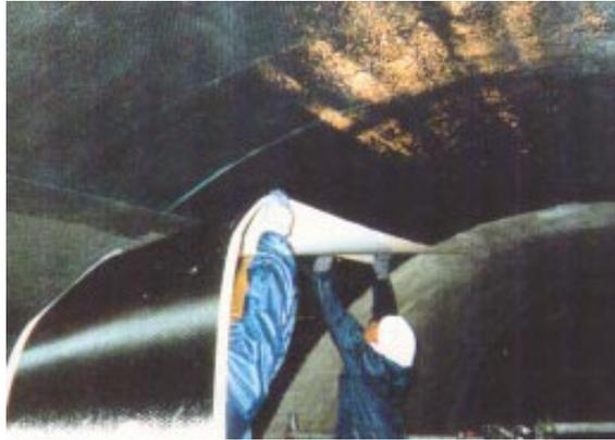
Figura 2.6 – Reparo de túnel com CFC (Karbhari, 1998).
