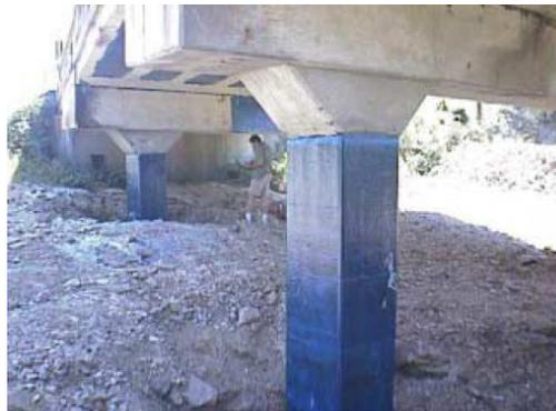
Figura 2.4 – Confinamento de pilares com CFC.
