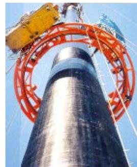
Figura 2.5 – Reforço de chaminé com sistema de fio de fibra de carbono sob tensão (Karbhari, 1998).
