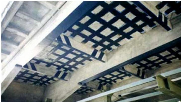
Figura 2.8 – Reforço de lajes à flexão e vigas à flexão e à força cortante com tecidos de CFC.
