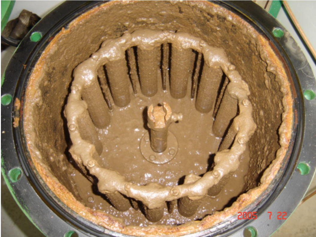
Figura 4 – Filtro de água antes da manutenção
