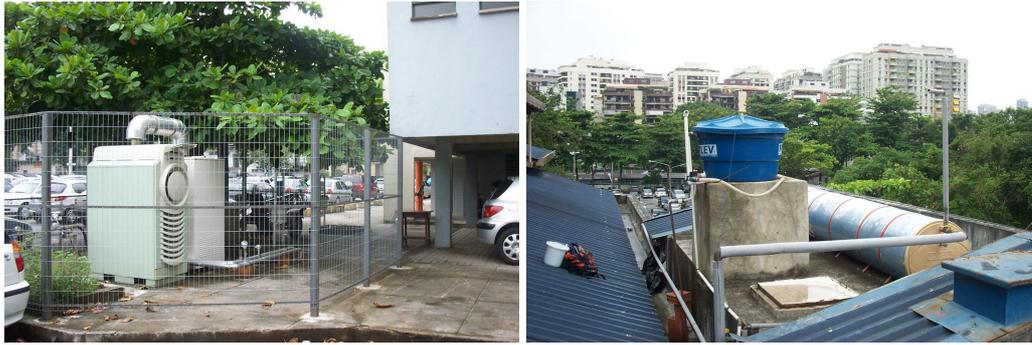
Figura 19 – Sistema de cogeração com microturbina a gás natural
