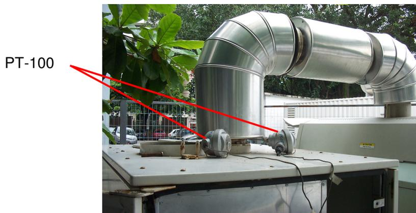
Figura 31 – Instrumentação – temperatura dos gases de exaustão
