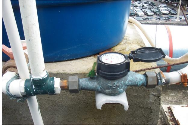
Figura 28 – Instrumentação - volume consumo de água quente
