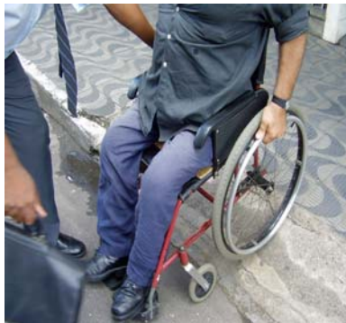
Figura 82 – “Rampas” com inclinação acentuada
