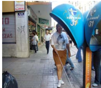
Figura 71 – Falta de piso de alerta ao redor do mobiliário suspenso
