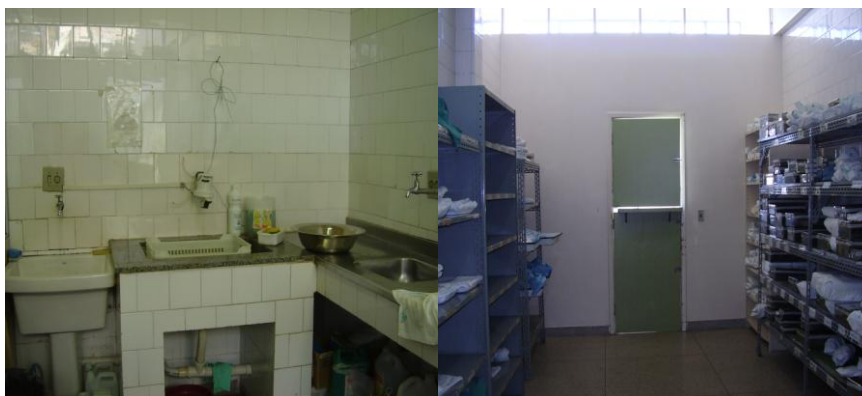
Figura 60 – Sub-setor expurgo (a esquerda) acondicionamento de materiais (a direita)
