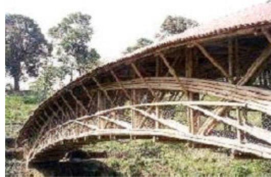
Figura 1.6 – Ponte de Bambu na Colômbia.
