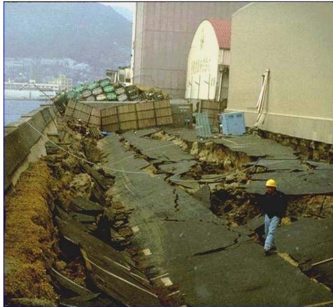
Figura 1.2 Recalque do terreno por liquefação junto a uma estrutura de contenção da Great Hanshin Bridge. (Earthquake Engineering Research Center, University of California, Berkeley. USA).
