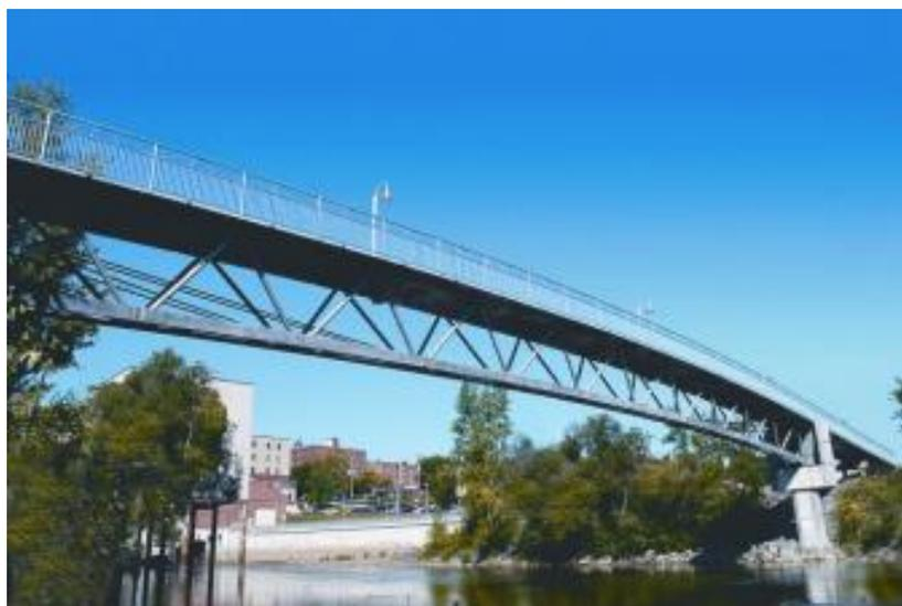
Figura 1-1 – Passarela de Sherbrooke no Canadá, construída com concreto de alto desempenho (9)
