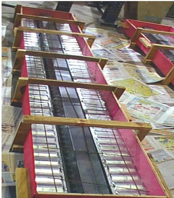
Figura 4.15 – Armadura de pele contra fissuração.
