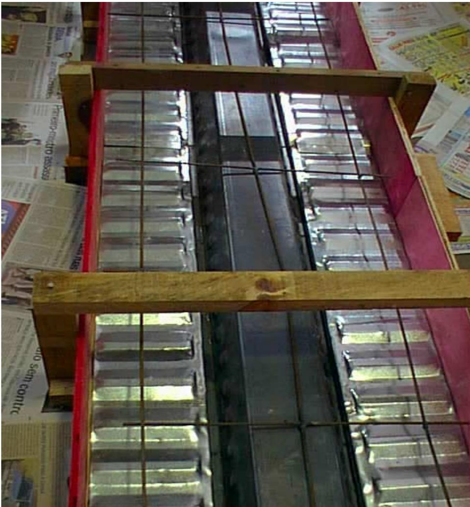
Figura 4.14 – Fôrma de contenção lateral temporária.
