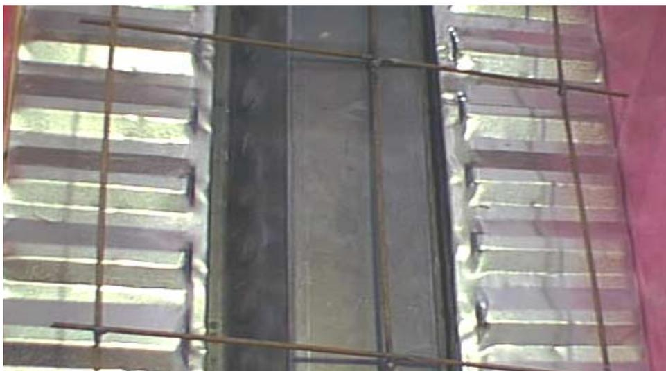
Figura 4.1 – Configuração perfil metálico e as duas chapas laterais.
