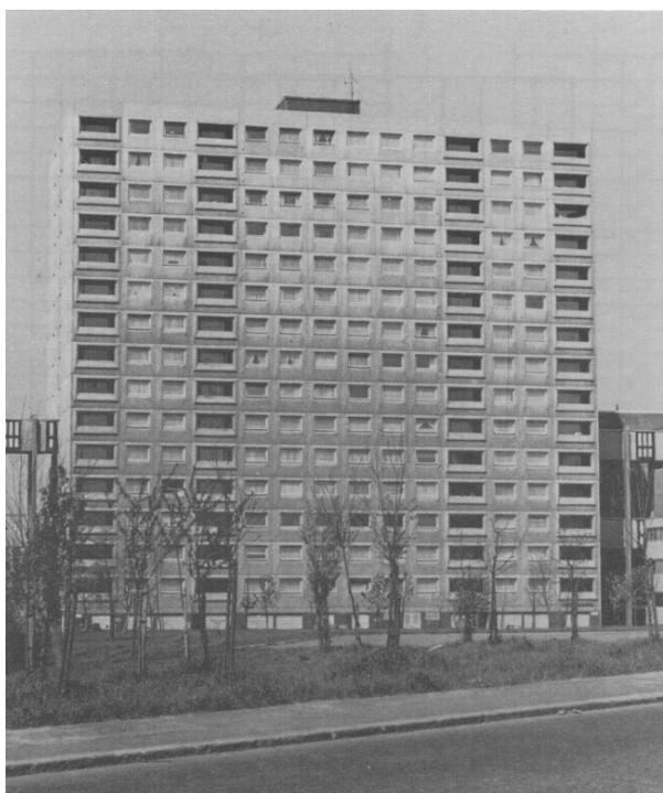
Figura 3. 1 – Prédio construído sobre radier estaqueado (apud Cooke *et al.*, 1981).
