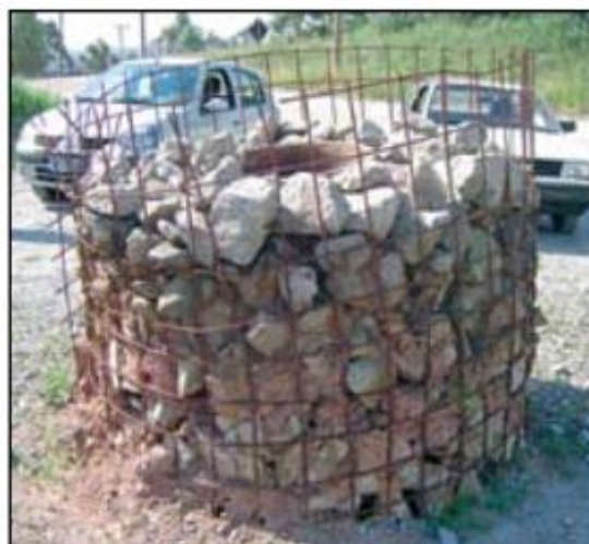
Figura 39 – Dreno típico de aterros, que pode ser adaptado e inserido no sistema de captação de biogás. Fonte: Acervo CENBIO.
