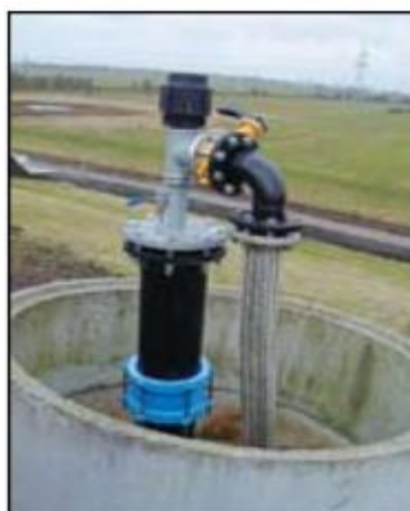
Figura 40 – Cabeçote de adaptação de dreno existente. Modelo utilizado na Europa e EUA. Fonte: Acervo instituto Agir.
