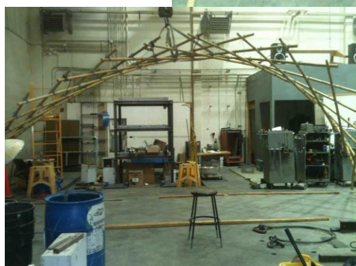
Figuras 135, 136 e 137: lateral do arco com cabos de suporte (135), soerguimento da treliça com guindaste formando o arco (136 e 137).
