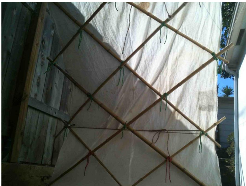
Figura 86: Armação do arco para verificação inicial da sua estabilidade.
