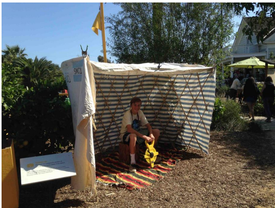
Figura 76: Forma final do shelter com cobertura de tecido de algodão.
