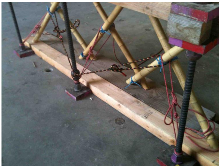
Figura 152: Ancoragem da base do arco com cordas tensionadas.
