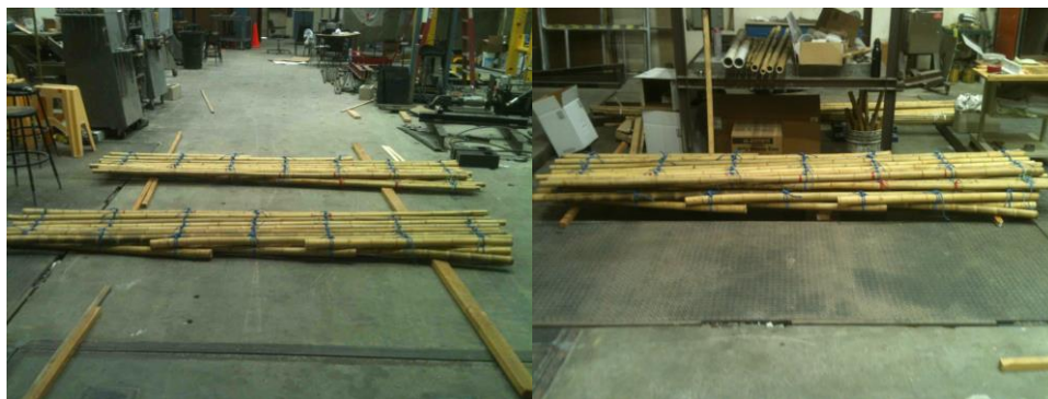
Figuras 140 e 141: Treliças separadas para compartimentação.
