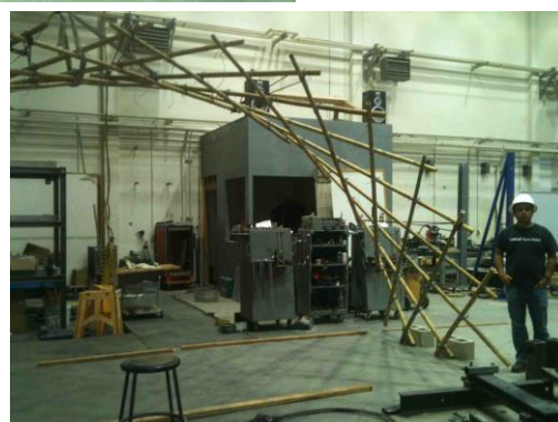
Figuras 135, 136 e 137: lateral do arco com cabos de suporte (135), soerguimento da treliça com guindaste formando o arco (136 e 137).
