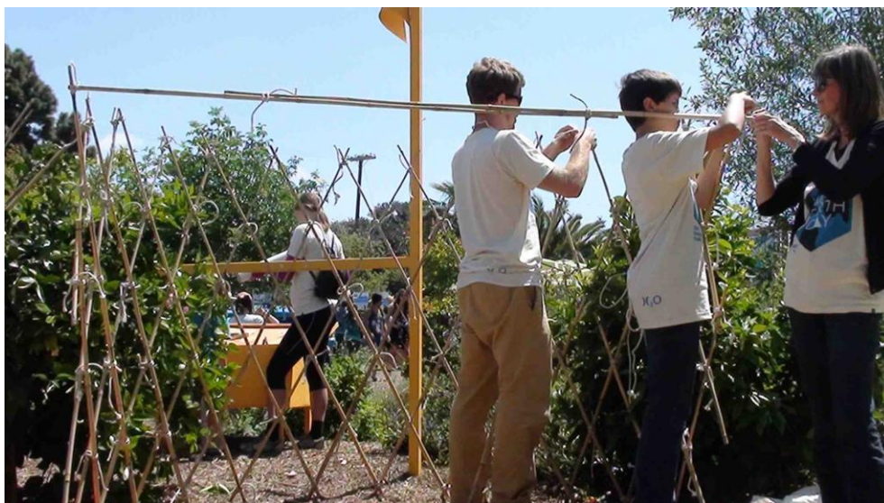
Figura 74: Posicionando colmos de bambu no eixo central da semicircunferência para estabilizar a cobertura de tecido de algodão.
