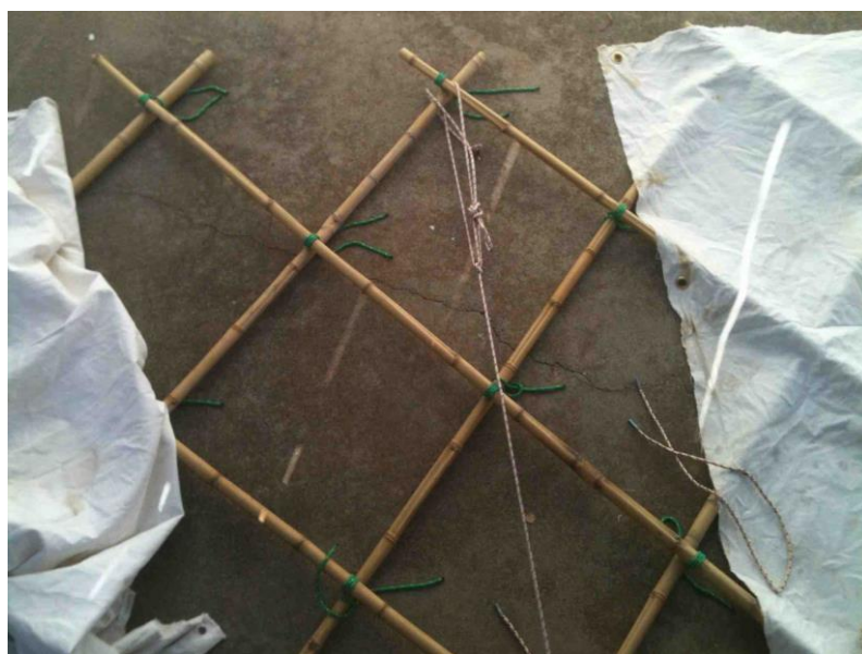
Figura 85: Colocação dos cabos transversais de suporte para a estabilização da treliça em arco.
