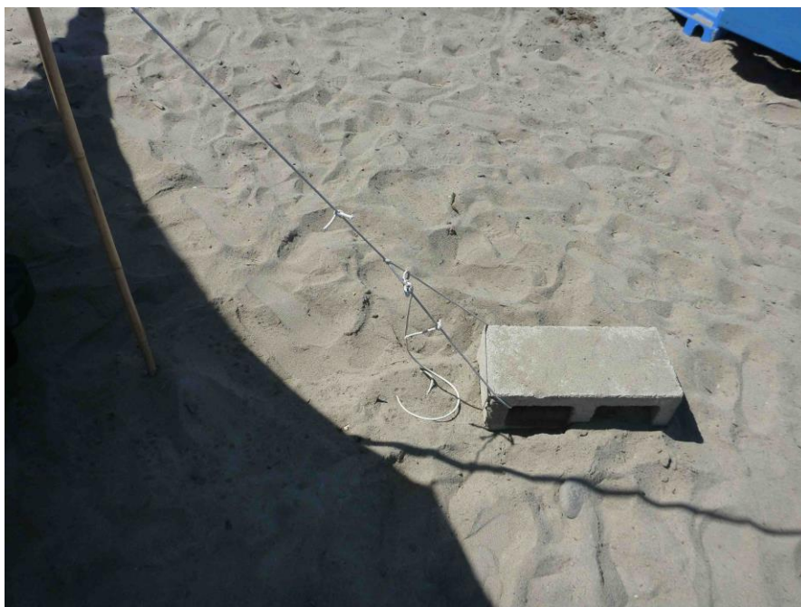
Figura 57: Detalhe da ancoragem da cobertura do estande, sem sinalização no cabo de suporte e no bloco de concreto, praia de Lower Trestles , 2012.
