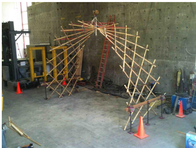
Figura 147: Arco pré-estabilizado, ainda com o guindaste dando suporte a ele.
