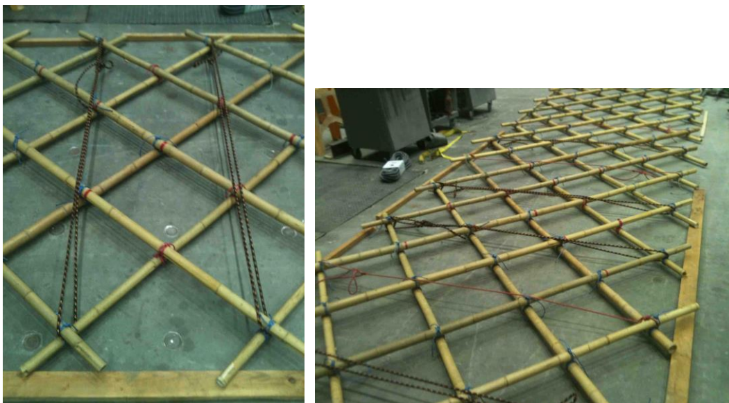
Figuras 138 e 139: colocação dos 14 cabos de suporte.
