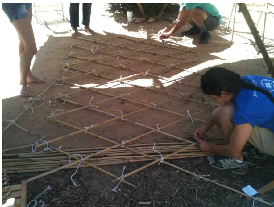
Figura 80 : amarração da treliça com o nó fiel (clove hitch)
