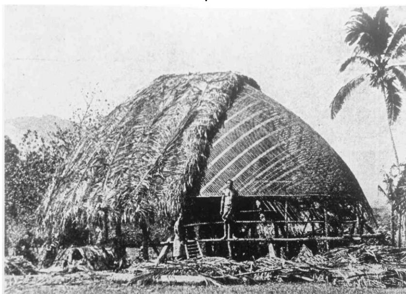
Figura 62: Samoa, Polinésia, Oceania, 1903, estrutura de bambu coberto com palha de cana de açúcar, piso de coral esmagado coberto com tapetes de relva.
