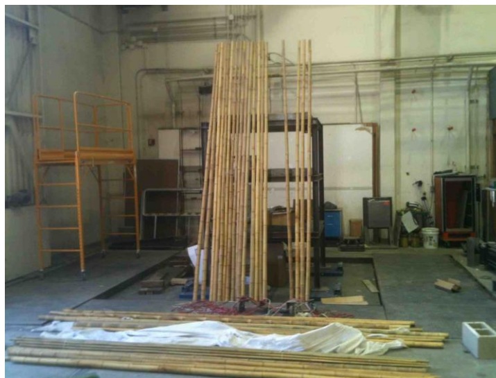
Figura 121: chegada dos bambus para a montagem do arco.
