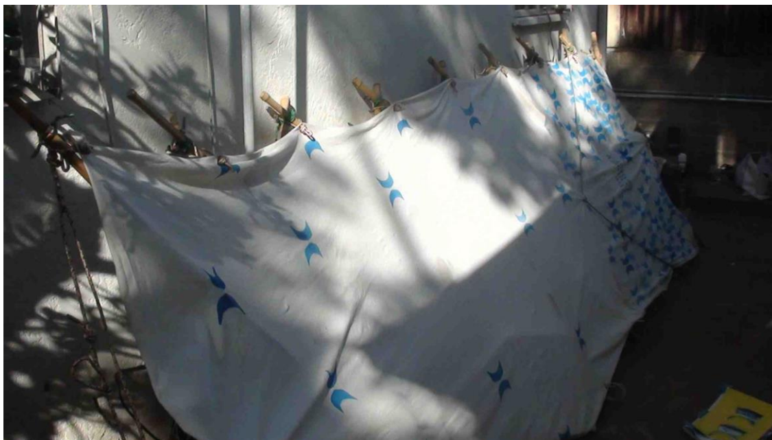
Figura 88: Finalização da pintura nos pontos mais manchados.
