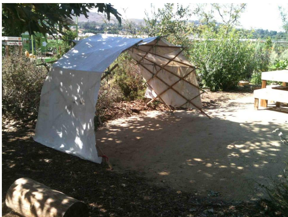
Figura 81: arco montado com um tecido de algodão na sede do The Ecology Center.
