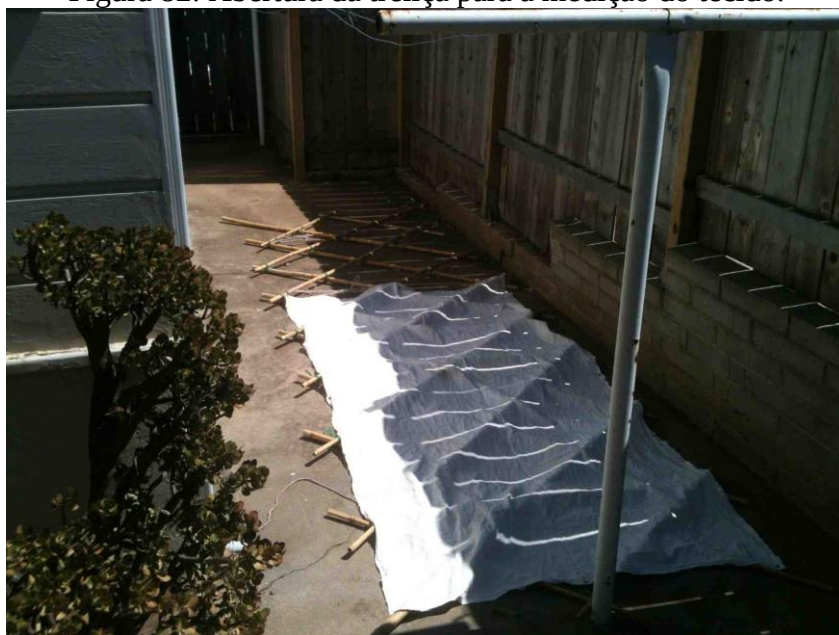
Figura 83: Colocação dos tecidos e medição dos pontos de amarração.
