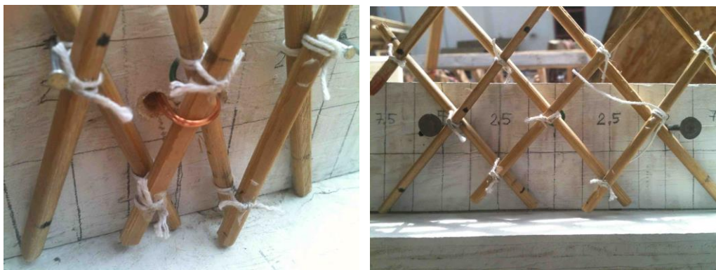
Figura 119 e 120: base do arco estabilizada na parede de madeira com arame ancorando (119) e com pregos limitando a abertura da treliça (120).
