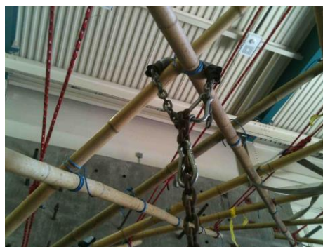
Figuras 153 e 154: Alças com mosquetões e correntes esticadas até a caixa de madeira.
