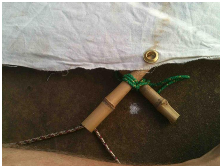
Figura 84: Ilhós situado na junta da treliça para a ancoragem no arco.
