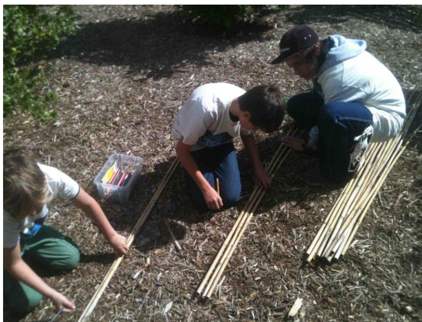
Figura 67: Marcação dos colmos de bambu para a amarração da treliça, The Ecology Center , 2014.
