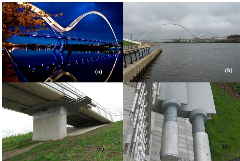
**Figura 1.1** - A ponte “The Infinity” que atravessa o rio Tees, nordeste da Inglaterra. (a) e (b) Curvatura variável da ponte. (c) e (d) Detalhe dos tirantes do arco. [Fonte: [http://en.wikipedia.org/wiki/Infinity\\_Bridge](http://en.wikipedia.org/wiki/Infinity_Bridge)]
