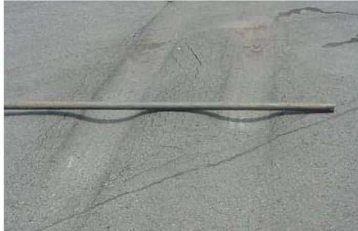
Figura 2.4 - Exemplo de deformação permanente em pavimento asfáltico (Franco, 2007)
