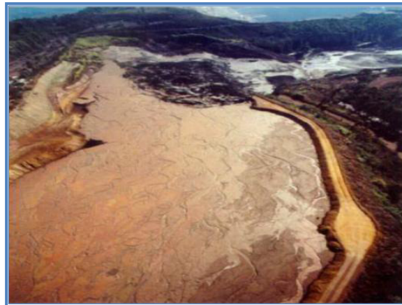
Figura 2-10: Vista aérea de montante para jusante da barragem de rejeitos da Cava C1 da Mineração Rio Verde que rompeu em 22/06/2001 (Estado de Minas,23/06/2001)
