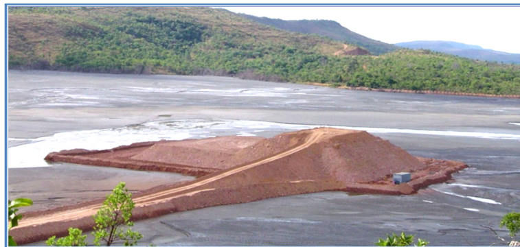
Figura 3-24: Final de terraplenagem do aterro Experimental, vista panorâmica (Ortigão, PRM 2005).
