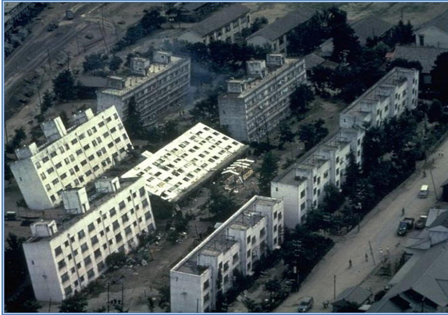
Figura 2-8: Colapso de obras civis por causa de liquefação da fundação
