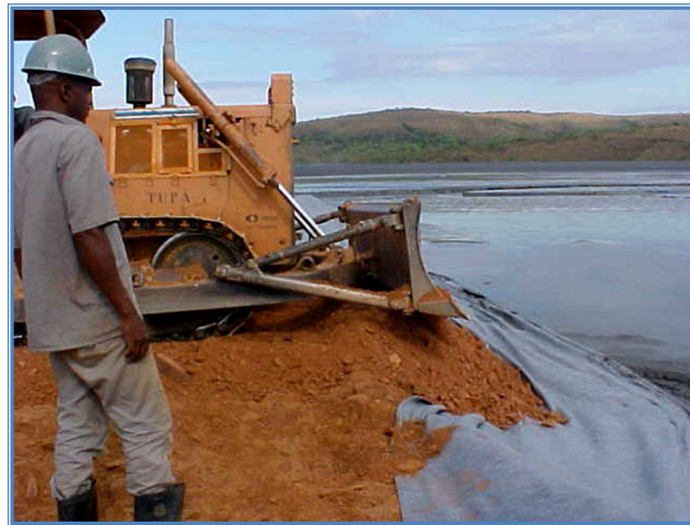
Figura 3-21: Colocação da primeira camada de terraplenagem sobre o geotêxtil.
