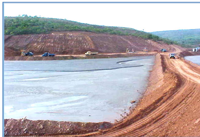
Figura 3-19: Material de empréstimo (Jazida), e estrada de acesso para o aterro experimental.
