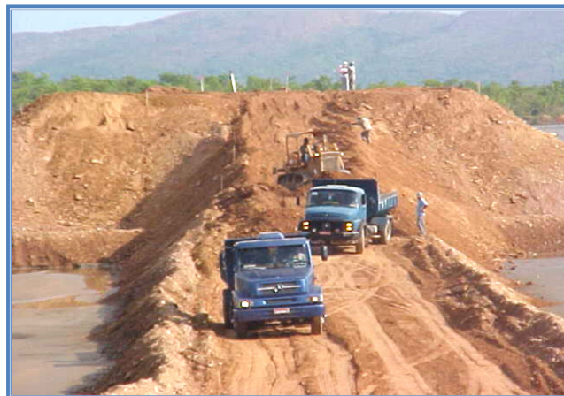
Figura 3-23: Fases finais de Construção do aterro experimental.
