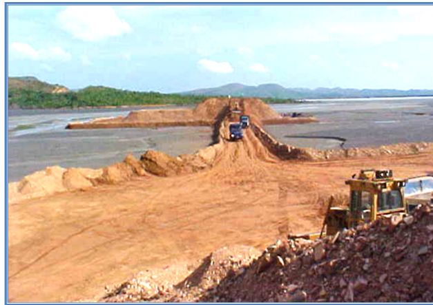
Figura 3-22: Fases de Construção do aterro experimental com altura de 5m de aterro.
