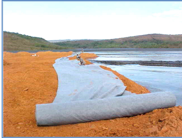
Figura 3-20: Colocação de geotextil sobre o aterro de conquista.
