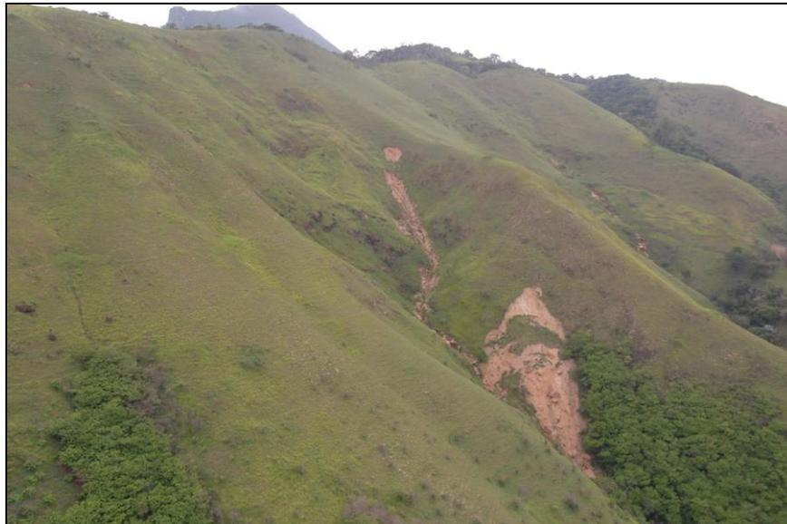
Figura 12: Movimentos de massa ocorridos sob cobertura de gramíneas em zonas de convergência de fluxos.
