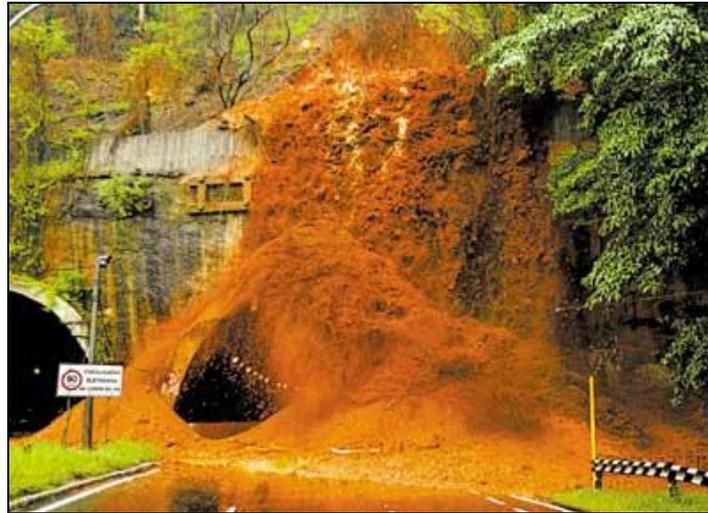
Figura 6: Movimento de massa na encosta a montante do túnel Rebouças, Rio de Janeiro, 2008.
