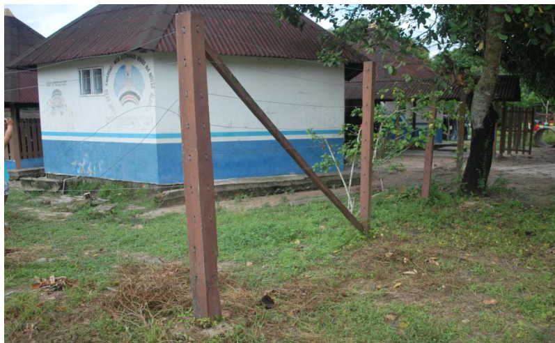
Figura 14. Detalhe da cerca de arame ao redor da escola
