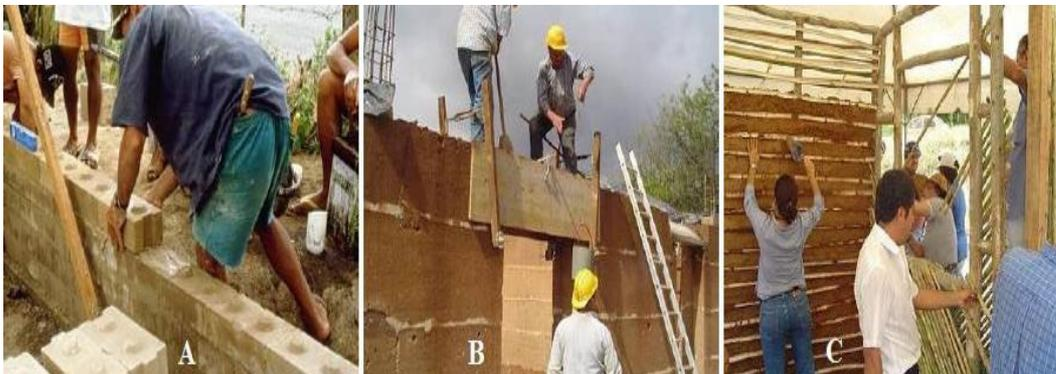
Figura 2.36: Modos de uso da terra: A) Alvenaria de blocos de terra comprimida; B) Paredes monolíticas (terra batida); C) Técnica mista (taipa-de-mão) (BARBOSA E GHAVAMI, 2007).
