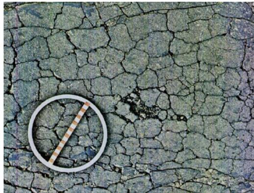
Figura 2.8: Trincas de fadiga (tipo “couro-de-jacaré”) de alto nível de severidade
