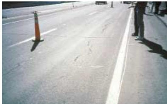
Figura 2.6: Trinca de fadiga de baixo nível de severidade (BELLINGER e MILLER, 2003)
