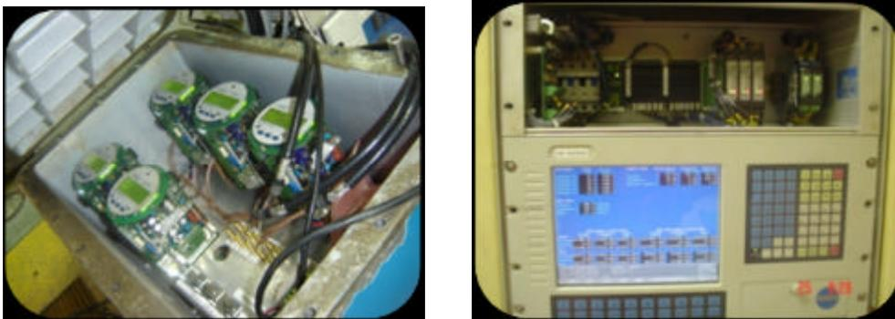
**Figura 12b – Unidades Conversora e de Processamento do Medidor Ultra-sônico**
