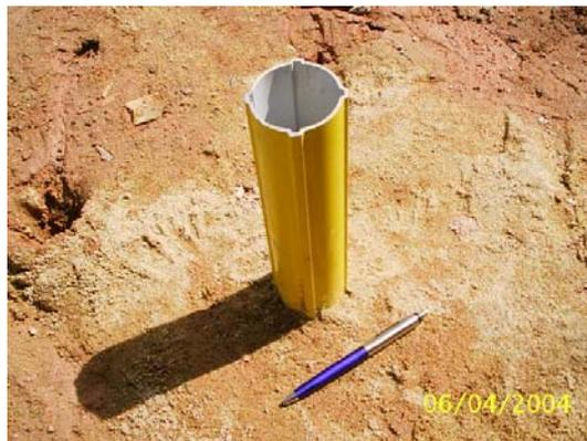
(b) tubo do inclinômetro instalado
