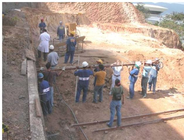
(d) instalação da barra no furo
