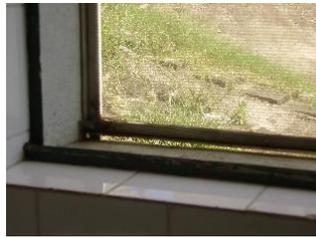
Figura 17 - Janela com proteção contra entrada de vetores
